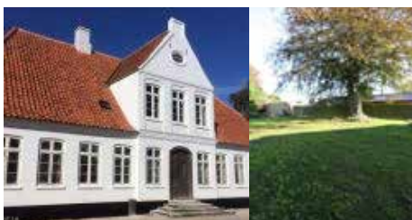
Facaden og haven oktober 2019
