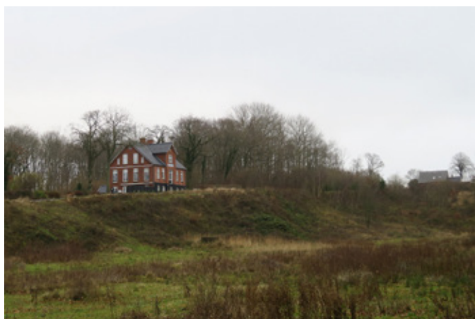
Teglværksejerens villa oppe på bakken på kanten af lergraven
