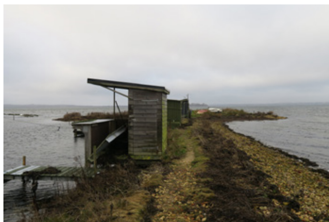
Anløbsmolen, der anlagdes som en bro, men blev til en mole pga. de mange tabte teglbrotter
